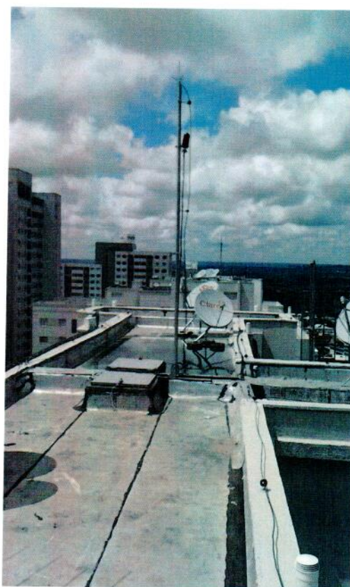
Figura 5 – Vista da laje de cobertura em reservatório elevado (Bloco C)
