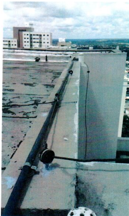
Figura 8 – Fixação de isoladores de porcelana e cabo de cobre nu em rufo/algeroz (Bloco C)
